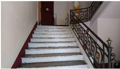
Pas de traitement des marches ; pas de réalisation d'une seconde main-courante ; pas de prolongement de la rampe.
